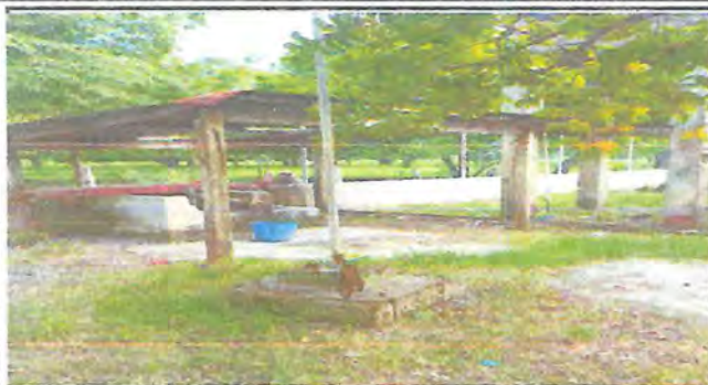
Foto 7: Estructura y techo de galera
