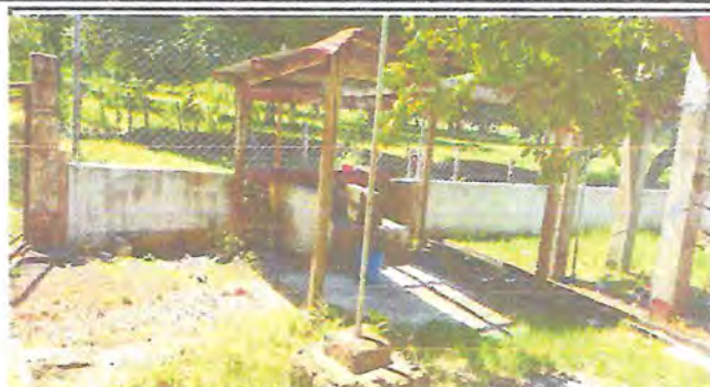
Foto 8: Estructura y techo de galera
